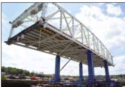
Krokové zdvihání mostu
