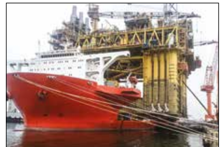
Synchronní zdvihání a spouštění
